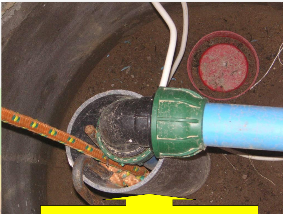
Rura osłonowa pompy głębinowej
